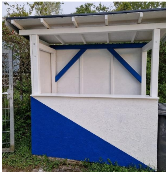
Neues Kassen-Häusle am Aachtalsportplatz
