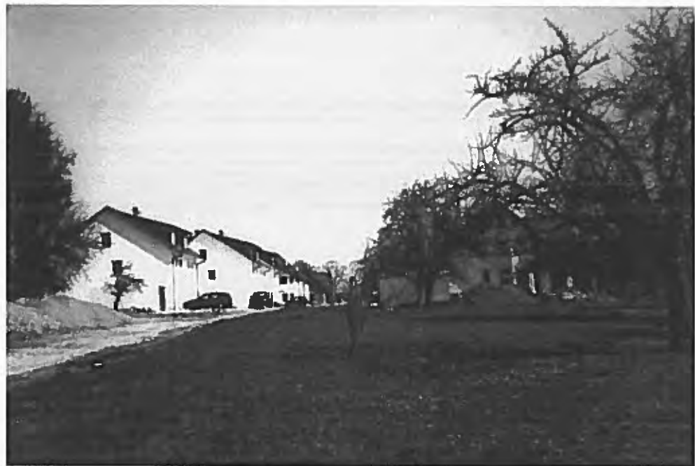
Abb 19: Neubaugebiet 'Allmend' am südlichen Ortsrand / Foto: Büro B•P
