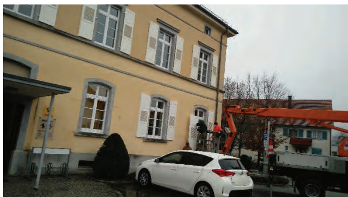
neu gestrichene Fensterläden am Rathaus
