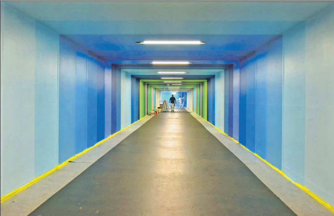
Auch im Maggi-Tunnel sorgt Videoüberwachung für mehr Sicherheit.
