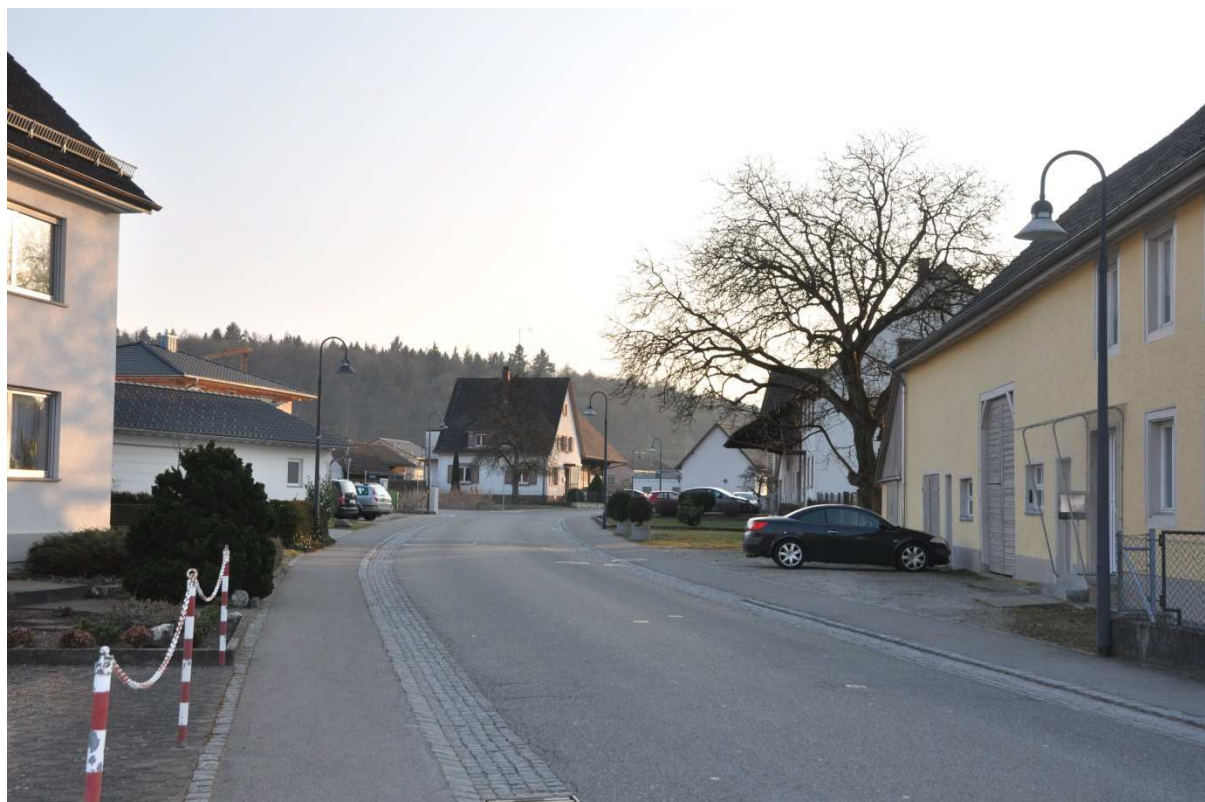
Abb. 40: Fahrbahneinengung durch gepflasterten Randstreifen, Bestand
