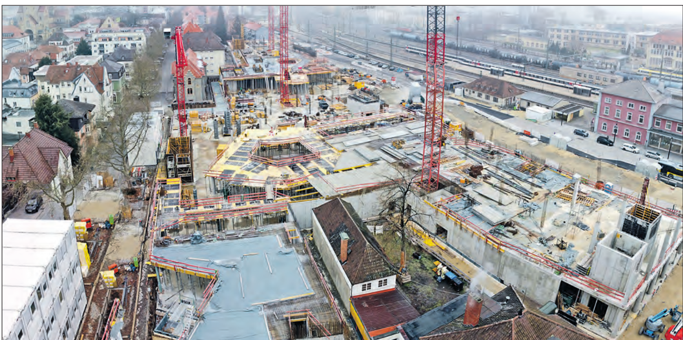
Für alle Fragen zur Baustelle für das neue Shopping-Center Cano und zum Bauablauf hat die ECE eine eigene E-Mail-Adresse eingerichtet: baustelle-cano@ece.com – unser Drohnen-Bild zeigt die Baustelle von Anfang Januar.
