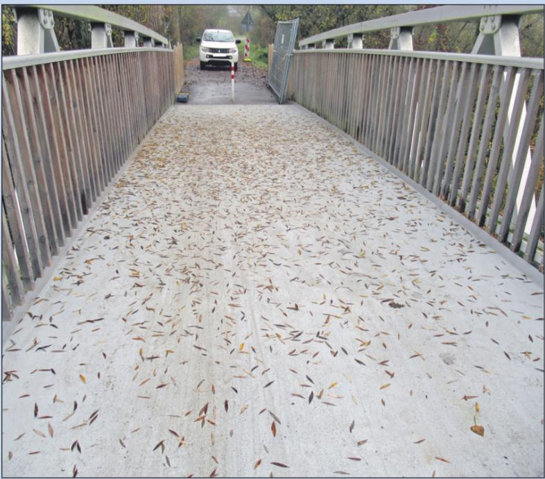
Die Haupt-Radfahr-Route zwischen Singen und Moos ist wieder offen: Die Aluminium-Brücke auf dem Radweg bei Rickelshausen hat einen neuen Belag mit einer speziellen Grip-Beschichtung erhalten, damit Radler/innen auch bei feuchter Witterung sicher das Brückenbauwerk überqueren können. Die Arbeiten dauerten nur knapp zweieinhalb Wochen.
