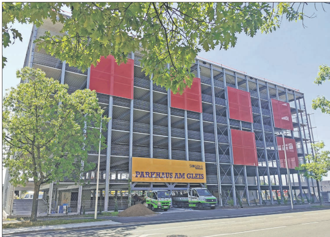
Das neue Parkhaus „Am Gleis“ in der Bahnhofstraße wird am Freitag, 1. Juli, um 14 Uhr offiziell eröffnet und steht dann der Allgemeinheit zur Verfügung. Auf einer Nutzfläche von rund 9.100 Quadratmetern sind in der Nähe zum Ärztehaus und zum CANO insgesamt 324 Stellplätze entstanden.
