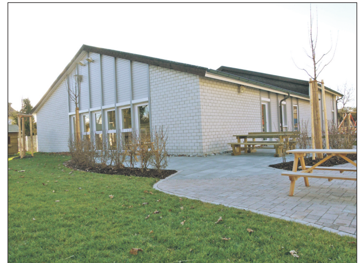
Im Januar letzten Jahres wurde mit den Umbaumaßnahmen im Gebäude an der Berliner Straße begonnen. Mitte September konnte man die Kita in der ehemaligen Versammlungsstätte der Zeugen Jehovas in Betrieb nehmen.
