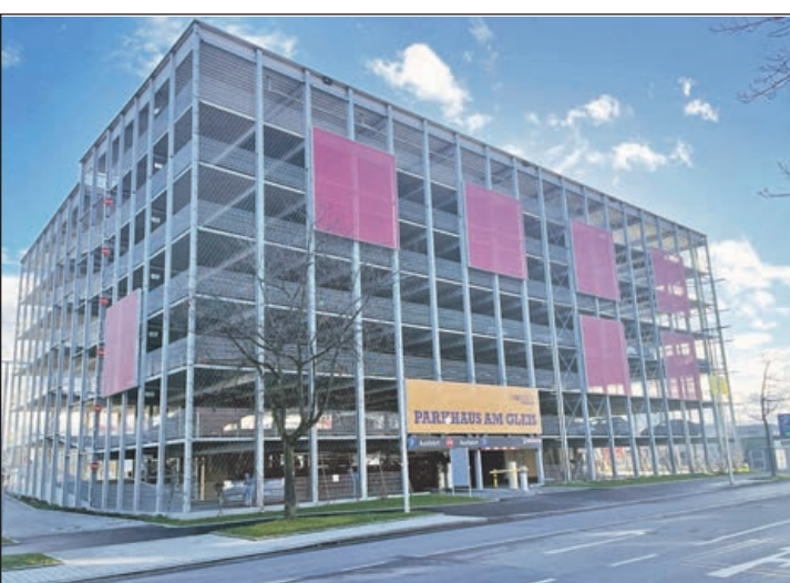
Im neuen Parkhaus „Am Gleis“ stehen Dauerparkplätze in der östlichen Innenstadt zur Verfügung.
