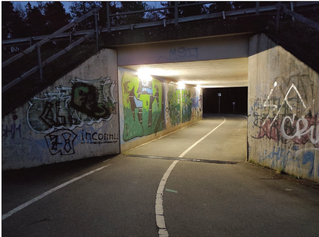
Die Radwegunterführung unter der B34 ist nun verkehrssicher gestaltet.
