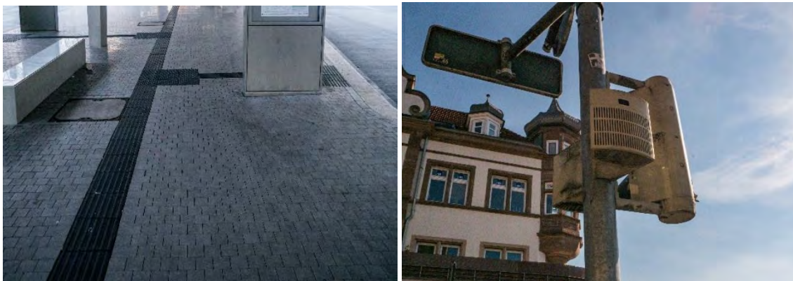
Abbildung 4: Blindenleitsystem und akustische Signalgeber
