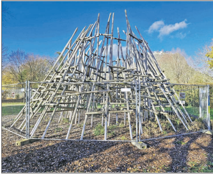
Der „Vulkan“, geschaffen für die Landesgartenschau 2000, muss nach 22 Jahren Nutzung demontiert werden.
