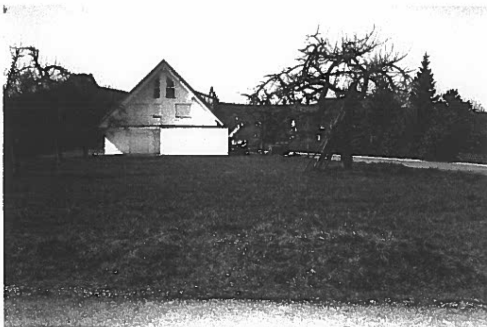
Abb. 16: Beispiel für innerörtliches Verdichtungspotential / Foto: Büro B•P
