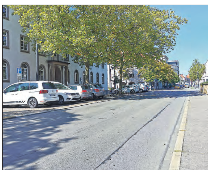
Die Alpenstraße wird zwischen der Ekkehard- und Hegaustraße saniert.
